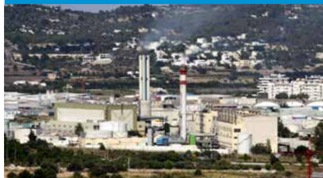
Central térmica GESA
